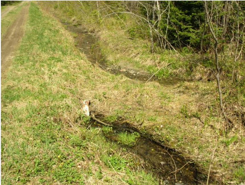
Figure 8. Le drainage est divisé en 2 au lieu d'avoir un seul bassin de drainage (bonne pratique)
